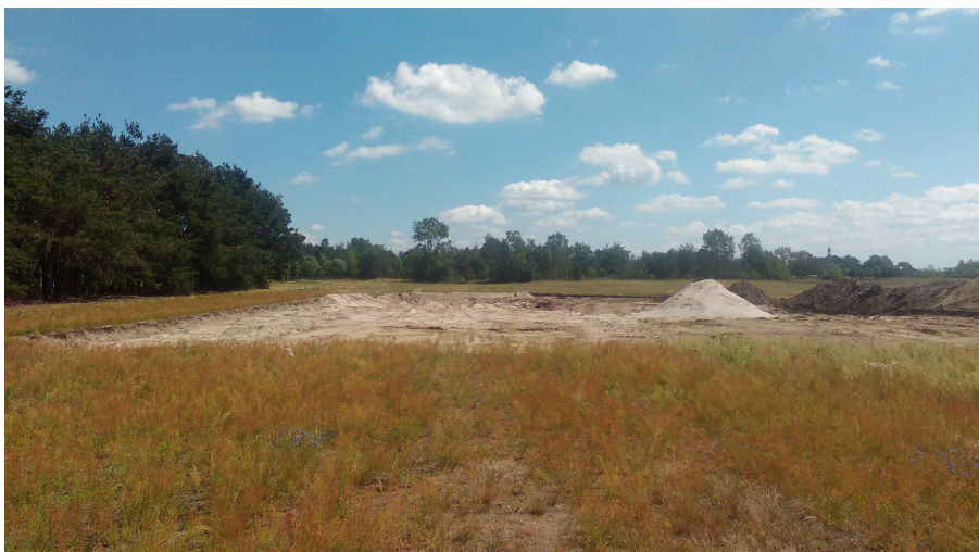
Fot.2. Realizacja zbiornika wodnego we wschodniej części analizowanego obszaru – Pole B złoża „MAURZYCE” (widok w kierunku wschodnim)
